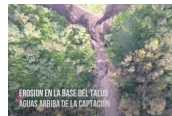
Imagen 3. Deslizamientos de taludes por la lluvia, 2022 Fuente: Canal Youtube FICA
