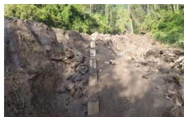
Imagen 2. Mal estado de las quebradas, 2022 Fuente: Canal Youtube FICA
