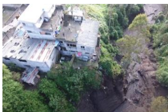
Imagen 1. Construcciones en borde de quebradas, 2022 Fuente: Canal Youtube FICA
